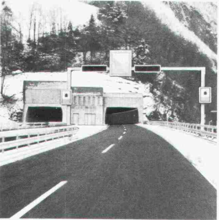
... wo Strassentunnels sicher sein müssen
