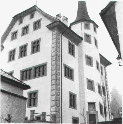
... wo historische Bauten gefährdet sind
