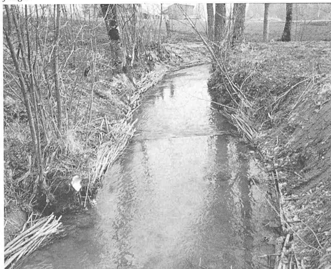
Bild 7. Rotbach: Unterspülte Gehölzufer werden mit Uferfaschinen unterfangen
