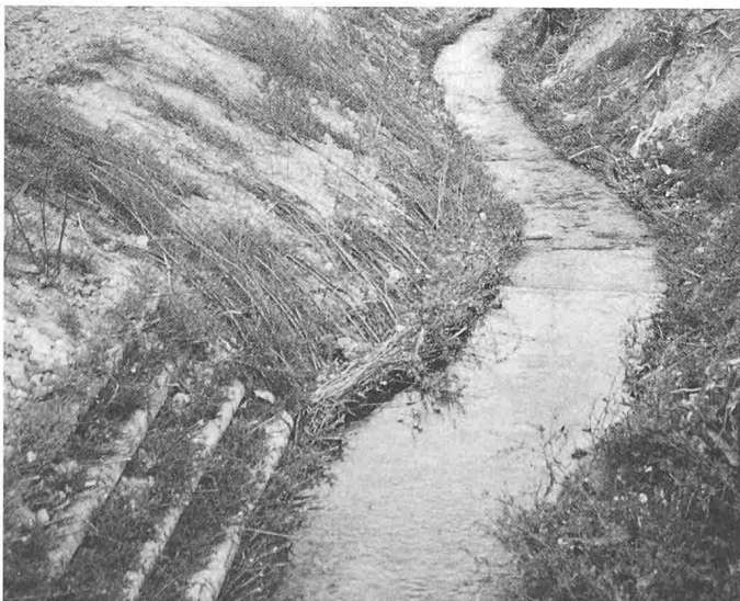
Bild 3. Schwarzbach: Spreitlage mit Uferfaschine und Holzgrünswelle 1 Monat nach Einbau im Austrieb
