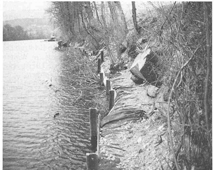
Bild 12. Häfli: Geotextilwalze hinter Eisenbahnschienen
