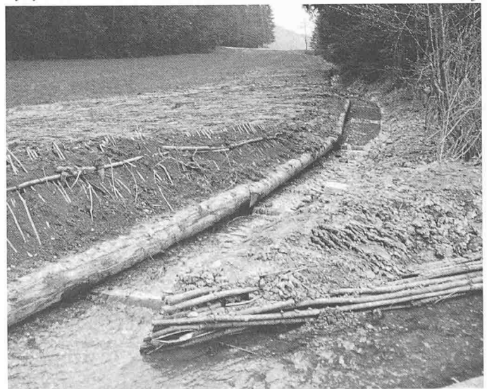
Bild 8. Rotbach: Spreitlage mit Längsholz als Fussicherung, im Vordergrund Uferfaschinen
