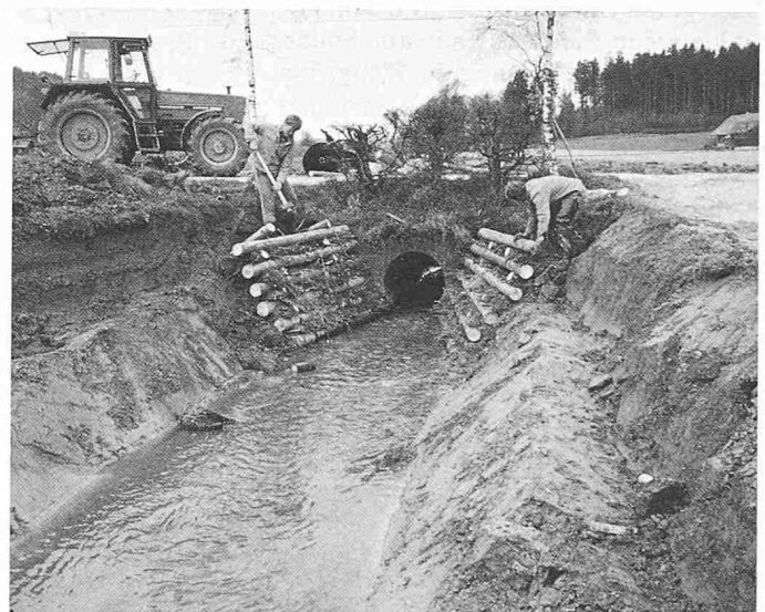
Bild 2. Schwarzbach: Holzgrünswellen bei Ein- und Ausmündungen von Rohren werden vom Gemeindewerk erstellt
