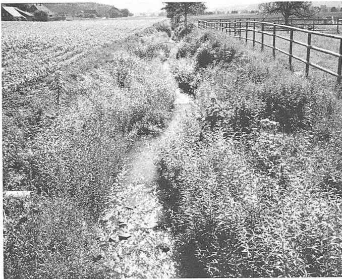
Bild 5. Schwarzbach: Aufwuchs der ingenieurbioologischen Verbauungen nach 3 Monaten
