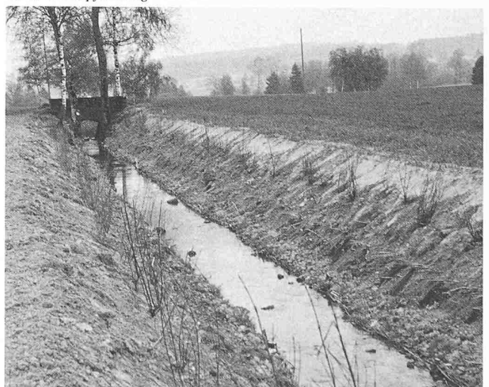
Bild 4. Schwarzbach: Ingenieurbioologische Uferstabilisierung mit Strukturmatte und Bepflanzung
