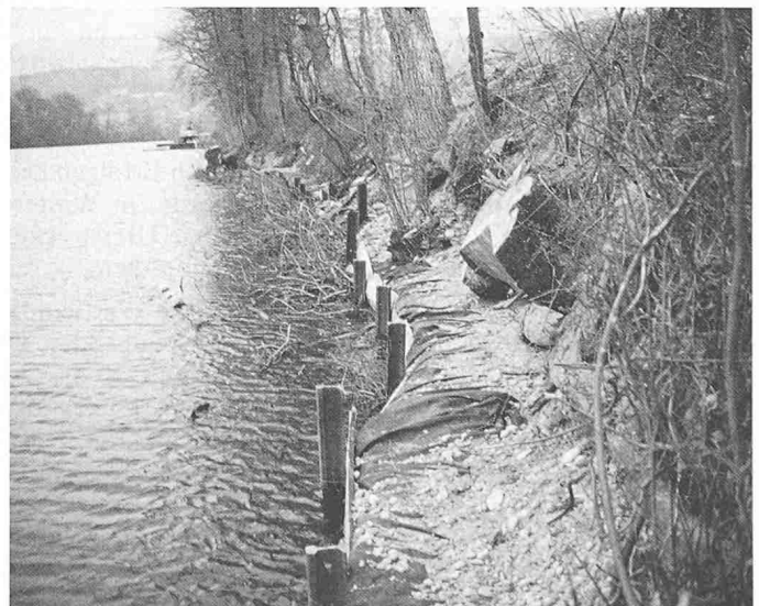
Bild 12. Häfli: Geotextilwalze hinter Eisenbahnschienen
