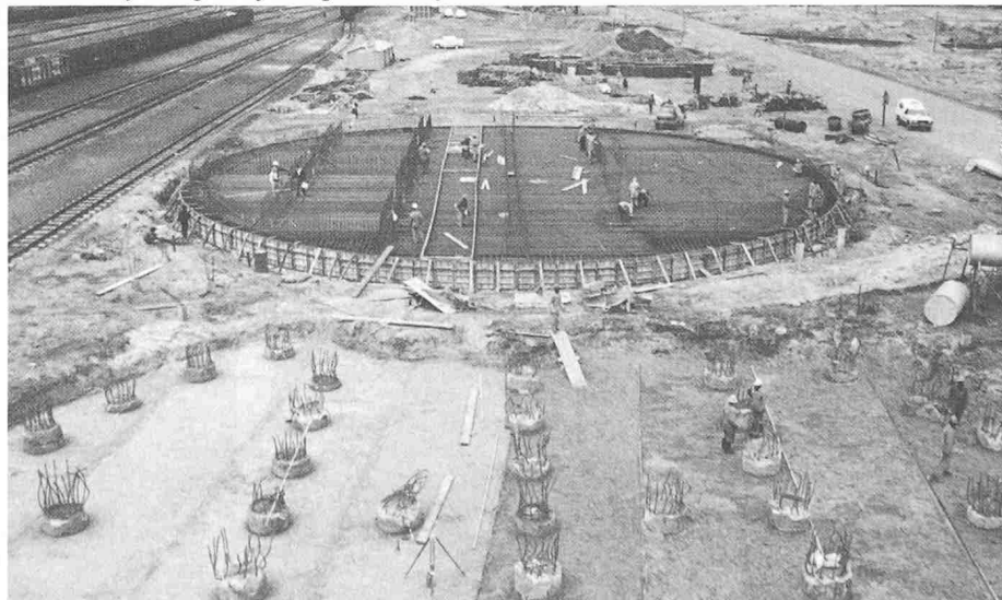
Bild 2. Ausführung von Pfählung und Bodenplatte
