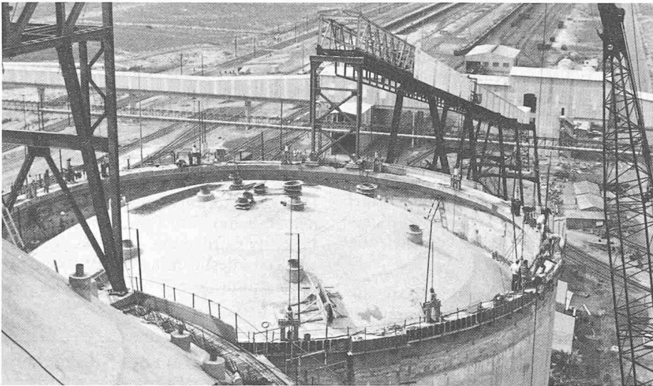
Bild 8. Schlussphase der Hebung des Daches des ersten Tonerdesilos
