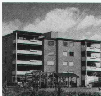
Foto: Peter Weber, BBI Bauberatung und Bauinformation
