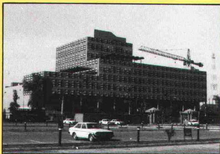
Immobilien Komplex in Baghdad (Irak)
