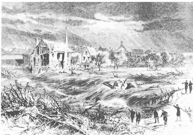
Bild 1. Die Überschwemmung in der Ostschweiz: Töss im Tössstal während des Unwetters. Nach einer Zeichnung von Joh. Weber
