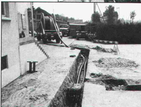
FLEXWELL-Leitungen von der Rolle in den Graben
