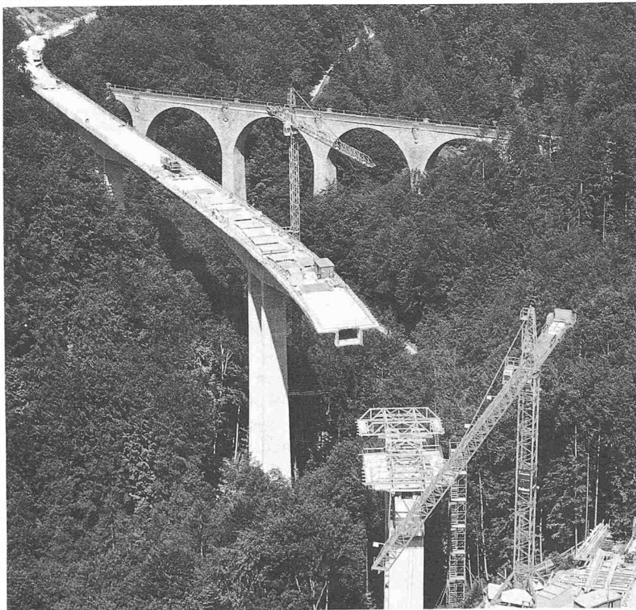
Bauzustand Freivorbau S3 und S4, Herbst 1984
