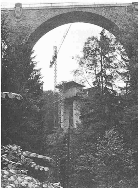
Durchblick bei alter Brücke auf Grundetappe S2
