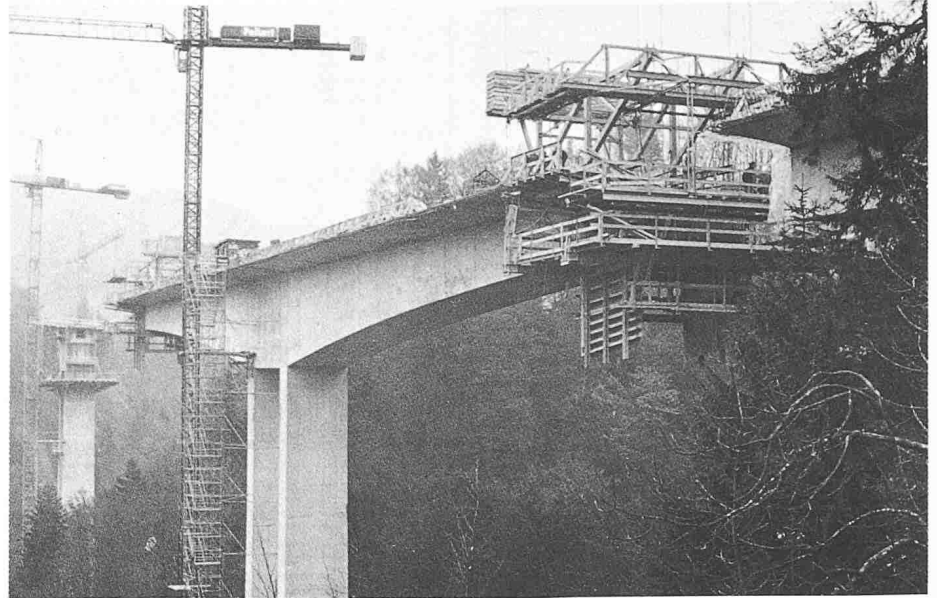
Bauzustand des Vorbauwagens, Etappe 16 bei Freivorbau S2
