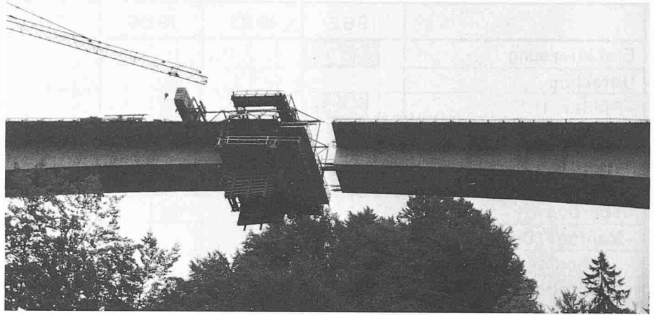
Vor Fugenschluss S2/S3
