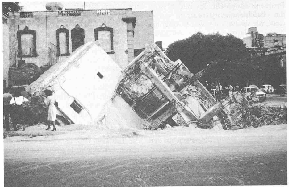
Bild 22. Dieses Gebäude kippte infolge Versagens der Reibungspfähle
