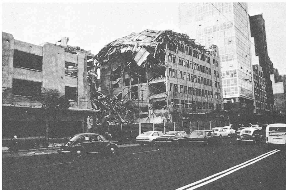
Bild 24. Obwohl die obersten Stockwerke total einstürzten, blieb die Tragstruktur der unteren Geschosse stehen
