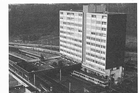
Station Worblaufen der SZB und VBW Die Station ist sechsgleisig, teilweise überdeckt, Hochhaus
