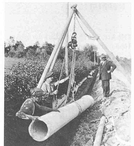
Bild 4. Verlegung des Betonrohrs für Telefonleitungen als Arbeitsbeschaffung 1921–1924
