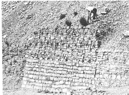
Links: Aufforstungs- und Verbauungsprojekte Urseren, Brienz (links) und Glyssibach (Bauherrschaft beider Projekte: Staat Bern). Urseren, Lawinerverbau: Kolktafeln zwischen den Bäumen auf dem Kamm zur Verhinderung der Gwächtenbildung, Stahl-Schneebrücken Voest-Alpine, Betonmauern und Schneenetze in Runsen mit Wasserabfluss. Glyssibach, Terrainverbau: Mauerterrassen (aufeinandergeschichtete Steinkisten und Steinkörbe) zur Beruhigung der Erosion, Aufforstung und Begrünung zwischen den Mauern (Foto: J. Chevalier)
