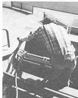
Bild 3. Kernbohrungen werden an 37 kritischen und wichtigen Stellen ausgeführt. Sie umfassen alle Schichten der Konstruktion
