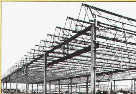
Metallstruktur eines Fabrikgebäudes mit Mini-Sheddach
