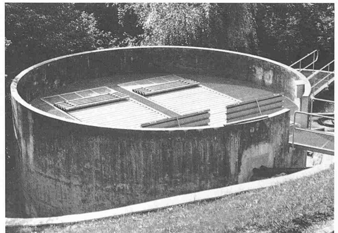
Bild 3. Einbau von zwei Tauchtropf-Körperanlagen im bestehenden Tropfkörper
