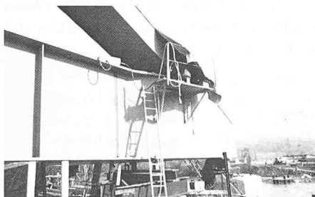
Bild 2. Montage der Aufhängungen und Querträger
