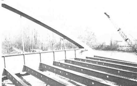
Bild 2. Montage der Aufhängungen und Querträger
