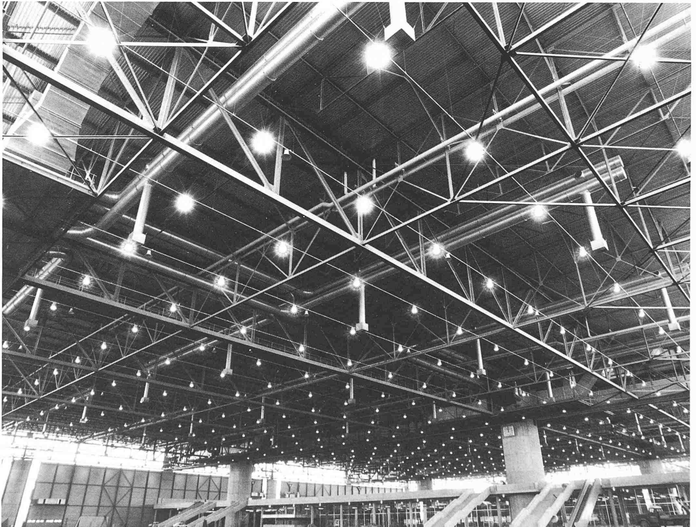
Bild 4. Innenaufnahme der Halle C mit Blick Richtung Halle B und A. Freie Höhe 18 bzw. 12 m, Bauhöhe des Dachtragwerks etwa 7 m
