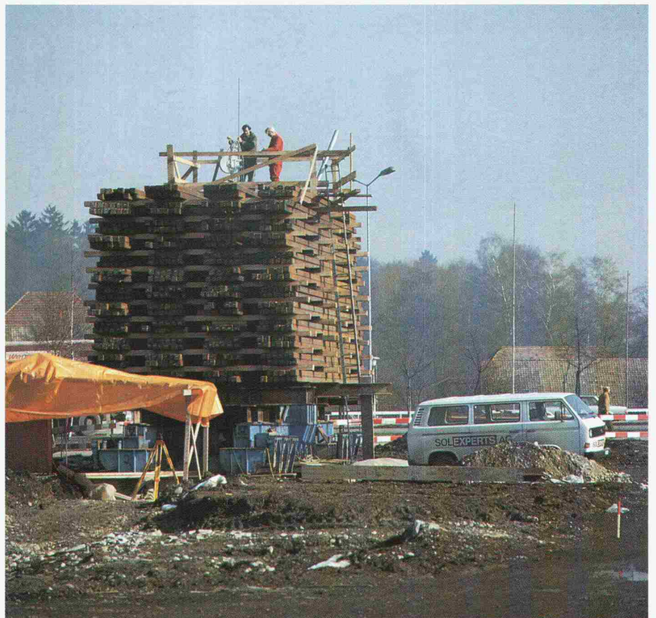
Pfahlbelastungsversuch Viadukt Neugut
