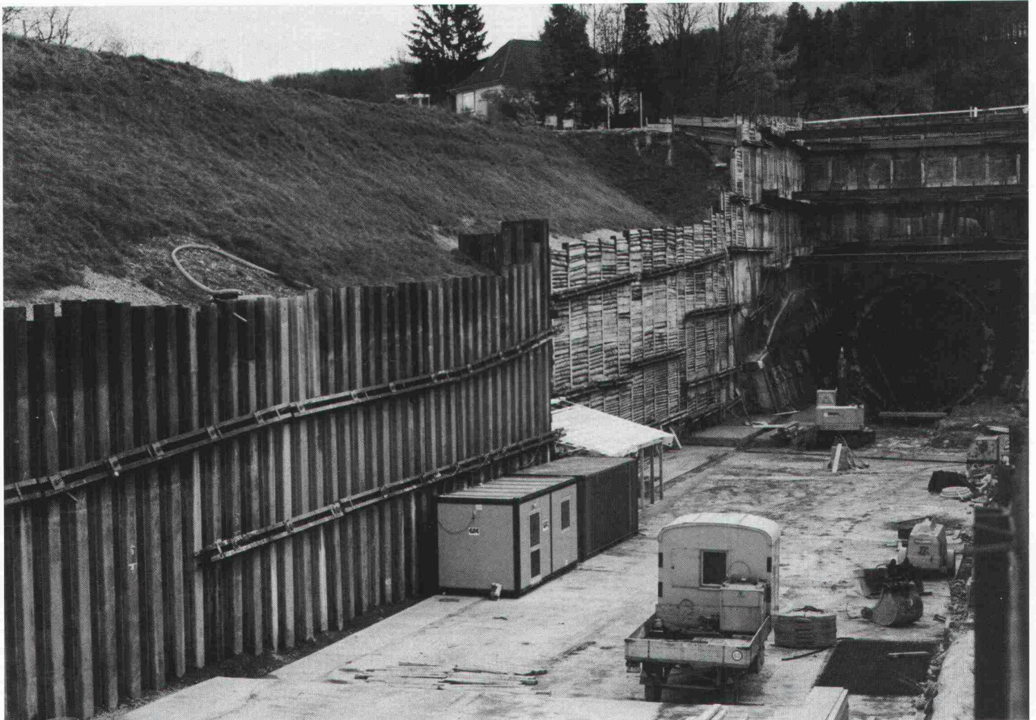
S-Bahn Zürich – Nordportal Zürichbergtunnel in Stettbach (Dübendorf)
