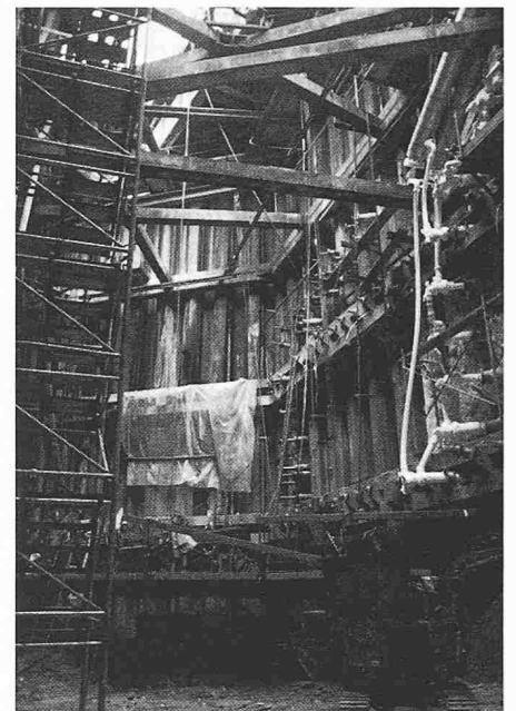
Bild 10. Schacht Limmat: Doppellangarinen mit Ankerköpfen; Gefrierrohre Axe 200 mit beginnender Vereisung
