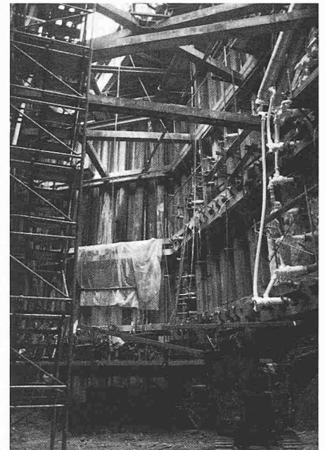
Bild 10. Schacht Limmat: Doppellangrinen mit Ankerköpfen; Gefrierrohre Axe 200 mit beginnender Vereisung
