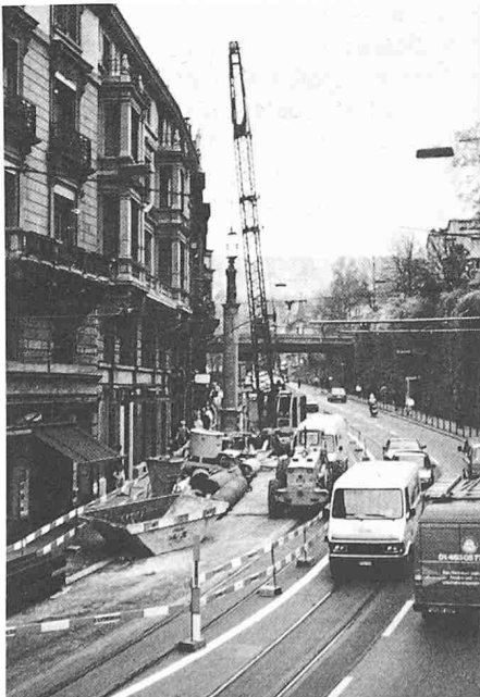
Bild 11. Erstellung der Bohrungen für Rühlwandträger
