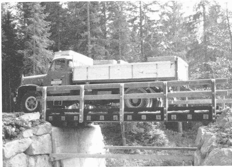
Die Brücke ist nach der Montage sofort befahrbar. Ein seitlich angebrachtes Schutzgeländer vervollständigt die Konstruktion. Bilder: ETH/E. Gehri
