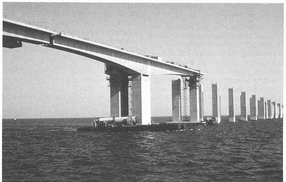
Bild 4. Freivorbaubrücke als Hauptnavigationsöffnung
