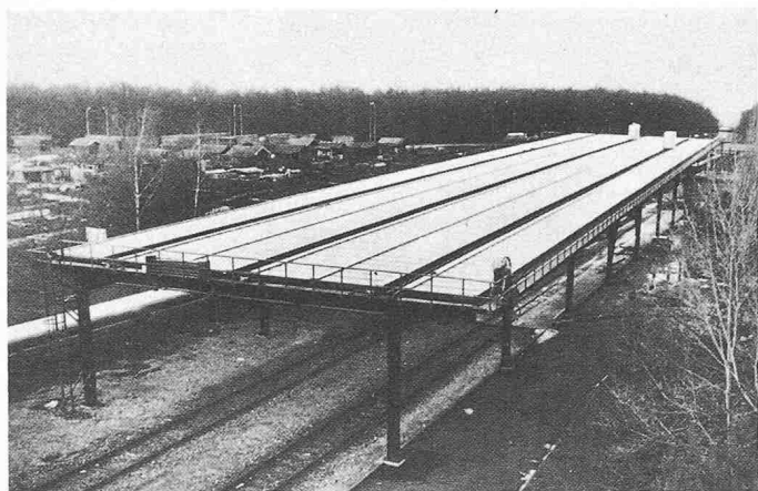
Bild 2. Die zweite schweizerische industrielle Solaranlage, erbaut im Jahre 1985, dient der Temperaturerhöhung der Rücklaufleitung eines Fernheiznetzes der Stadt Genf. Bei dem Entwurf des Kollektorenfeldes von 1000 m 2 konnten die Erkenntnisse aus der Rimuss-Solaranlage bereits mitverwendet werden
