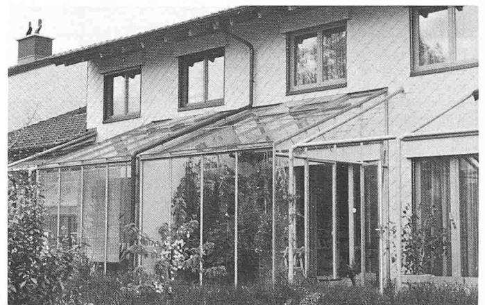
Bild 2. Der Wintergarten in Hünenberg ist ein Glashaushaus, das an ein Reiheneinfamilienhaus angesetzt ist. Es ist nur an einer Seite mit dem Haus verbunden und wird primär als Hobby-, Garten- und Gewächshaus benutzt (Betonung auf Garten).
