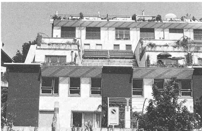
Bild 1. Der Wintergarten in Adliswil ist eine von 4 Seiten umgebene Terrasse in einer Terrassensiedlung. Die Terrasse ist mit einem Schräg-Glasdach als Wintergarten gestaltet. Der Wintergarten wird primär als Wohnraumerweiterung genutzt.
