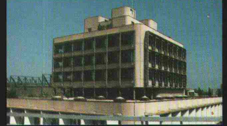
Sanierung PTT-Betriebszentrale Arlesheim ARLESHEIM/BL
