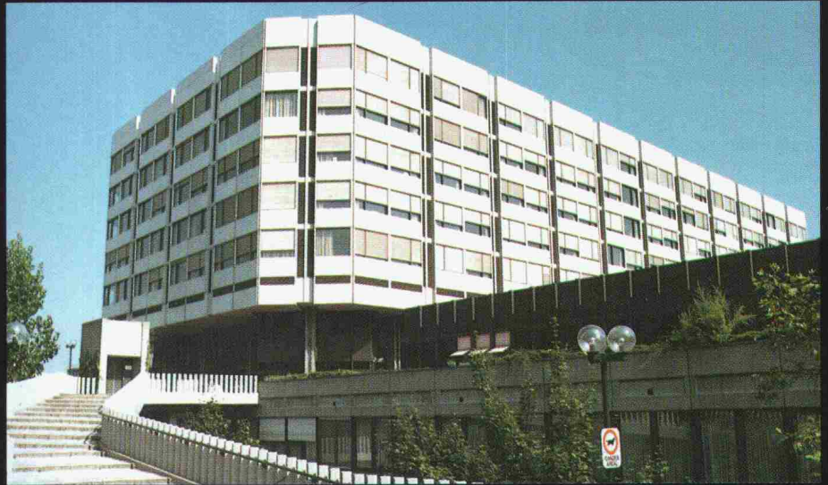
Sanierung Kantonsspital Basel BASEL
