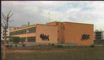
Schulhaus-Erweiterung « Collège de Mauverney » GLAND/VD
