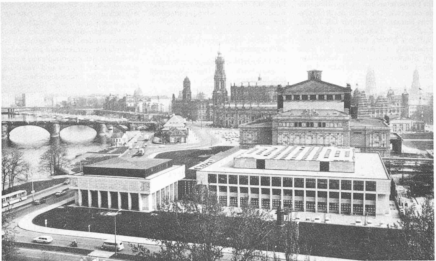
Der Baukomplex der Semperoper aus Nordwesten. Im Vordergrund das Funktionsgebäude mit der Probühne und der Gaststätte
