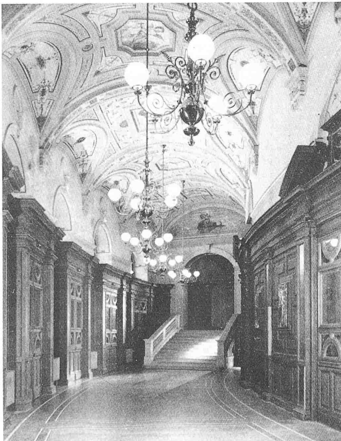
Unteres Rundfoyer. Die Rekonstruktion folgte der ursprünglichen Semperschen Gestaltung
