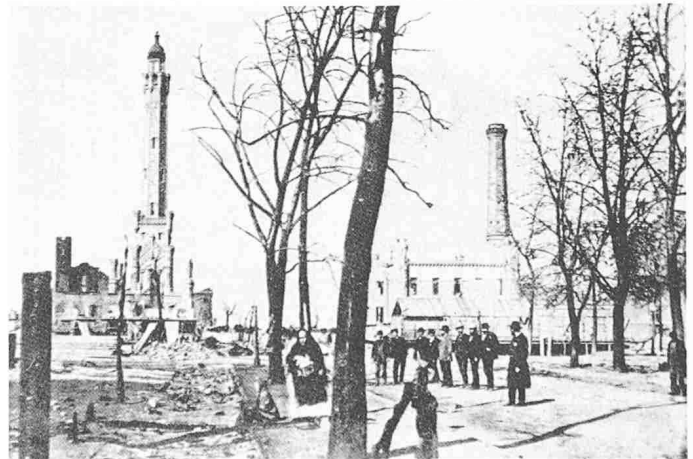
Nur der Wasserturm überlebte den Brand
