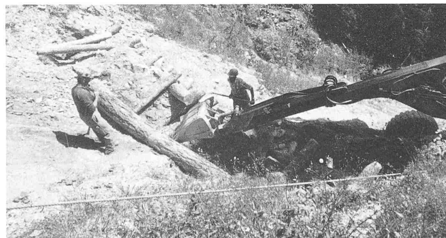
Fig. 4. Remplissage des caissons
