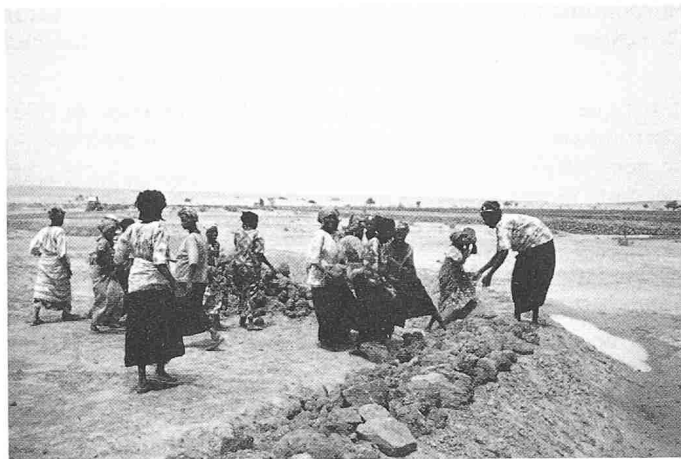
Fig. 3. Keita (Niger, 1985): murs anti-érosifs en construction
