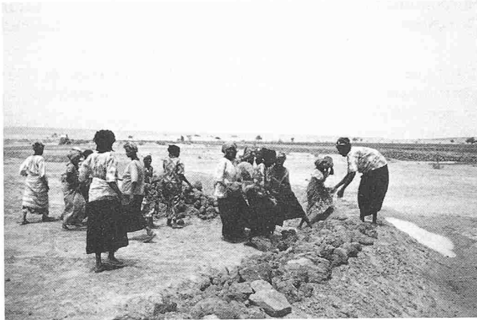
Fig. 3. Keita (Niger, 1985): murs anti-érosifs en construction
