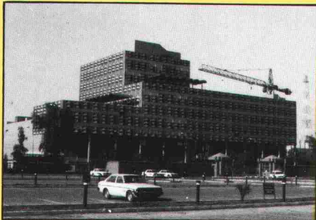
Immobilien Komplex in Baghdad (Irak)
