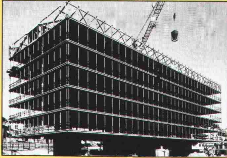
Stahlkonstruktion eines Verwaltungsgebäudes mit an den Dachträgern aufgehängten Zwischenböden
