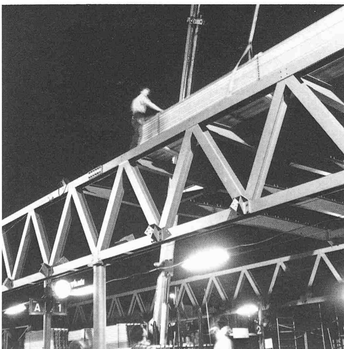
Bild 3. Für die Montagearbeit bei ausgeschalteter Fahrleitung standen nur kurze Nachtstunden zur Verfügung
