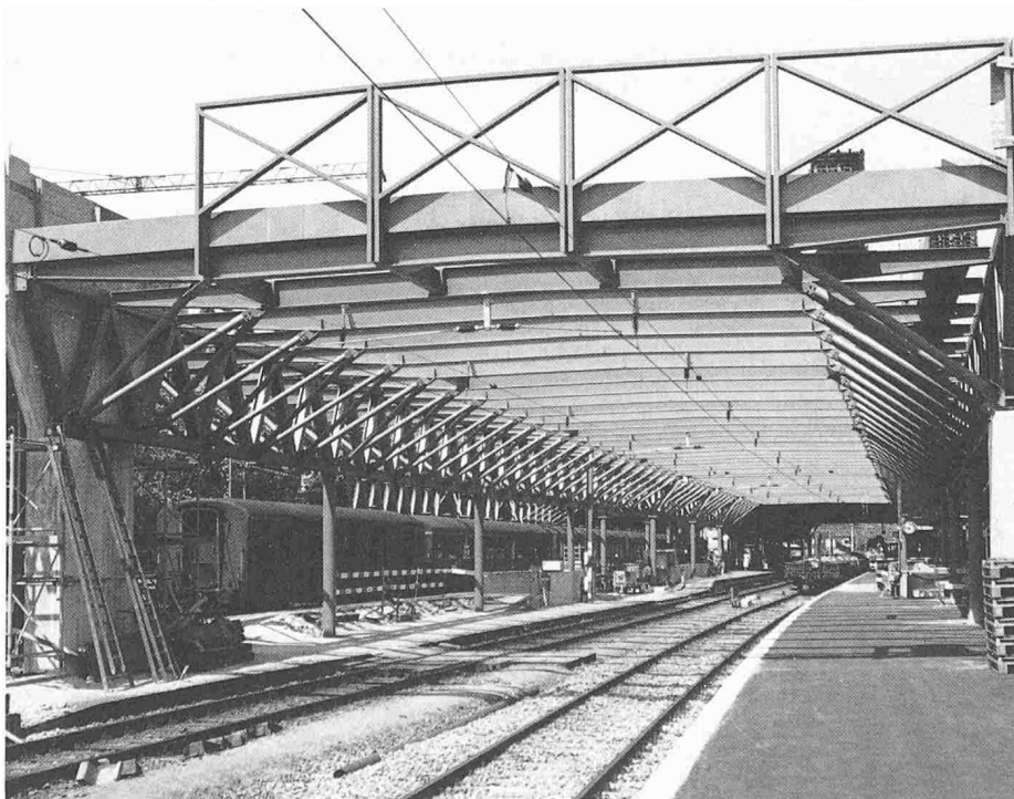
Bild 5. Überdeckung der Perronanlagen im Bau
