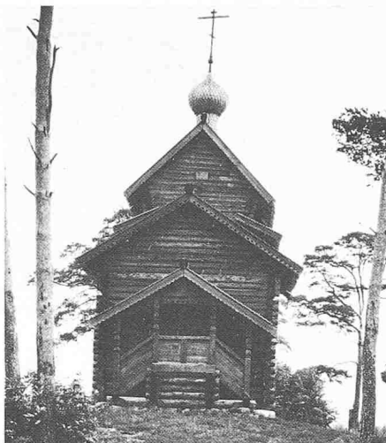
Traditionelle Blockbautechnik bei Novgorod (früher russisch-orthodoxe Kirche). Konstruktion und Massivität in einem
