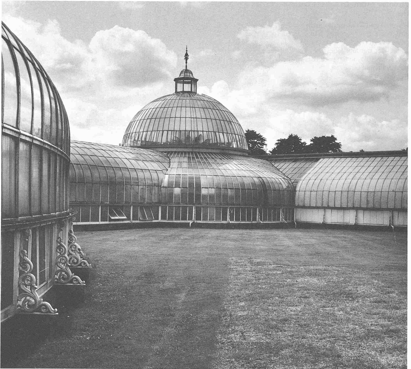
Kibble Palace heute botanischer Garten in Glasgow von Ingenieur James Kibble 19. Jh. Glaskuppel mit 17 m Durchmesser – ein Element der metallurgischen Architektur
