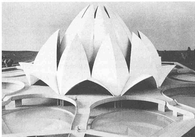
Bild 1. Modell des Baha'i-Tempels bei Delhi in Gestalt einer Lotusblüte aus mit Marmor verkleideten Betonschalen
