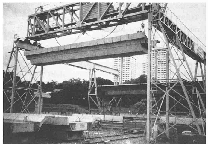
Bild 17. MRT Singapur: Heben eines 165 t schweren Spannbetonkastenträgers
