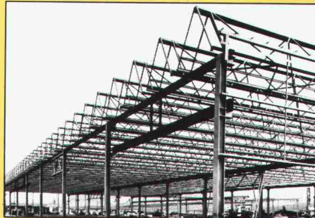
Metalstruktur eines Fabrikgebäudes mit Mini-Sheddach
