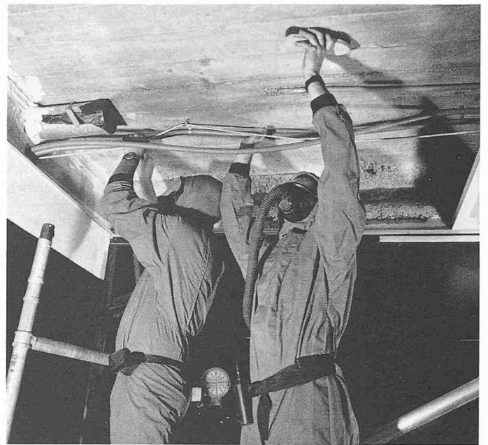
Bild 2. Zum Entfernen des Spritzasbests wird der Raum vollständig mit Kunststofffolien ausgekleidet und gegenüber der Umgebung auf Unterdruck gesetzt. Der Sanierende ist durch Schutzanzug und Vollgesichtsmaske mit Schwebstofffilter von der staubhaltigen Atmosphäre abgeschirmt.
