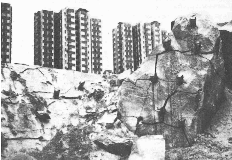
Bild 1. Zerstörungseffekt bei Verwendung von Expansionsmörtel nach 2 Tagen Einwirkungszeit, etwa 20 m 3 anstehender Fels
