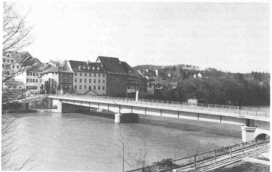
Bild 6. Ansicht (stromabwärts) der neuen Stahlverbundbrücke mit Blick auf Kaiserstuhl
