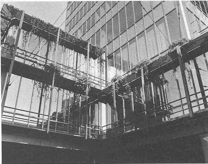
Übergang Eingangs- und Ladenbau
