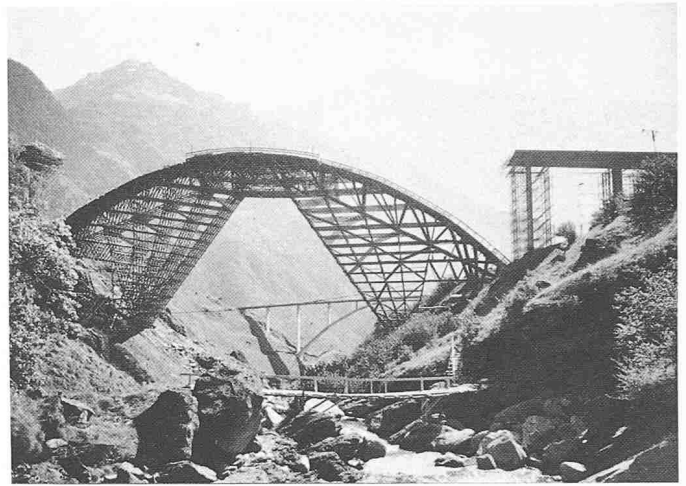
Bild 8. Lehrgerüst der Cascellabücke; im Hintergrund die Naninbrücke
