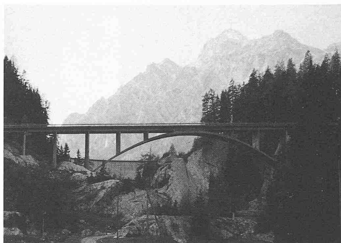
Bild 13. Crestawaldbrücke in der Ansicht
