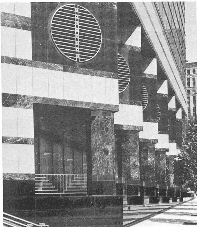
Sockelpartie, Detail Südseite mit Kolonnade und Lüftungs-Bullaugen
