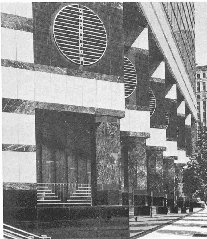
Sockelpartie, Detail Südseite mit Kolonnade und Lüftungs-Bullaugen
