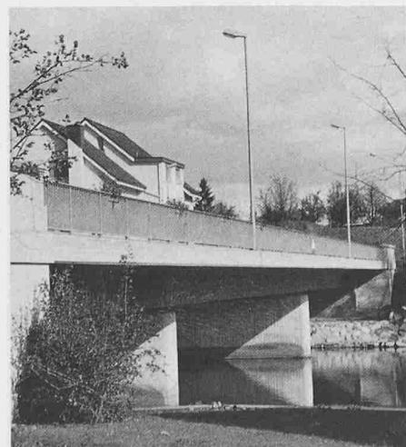
Bild 13. Die vollständig erneuerte Reussbrücke B-058 Gebenstorf-Windisch mit den natursteinverkleideten Widerlagern
