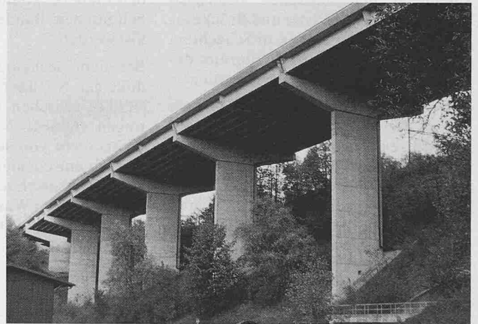
Bild 4. Das fertige Bünzthalviadukt, unsere preiswerteste Brücke, hat gelungene Proportionen
