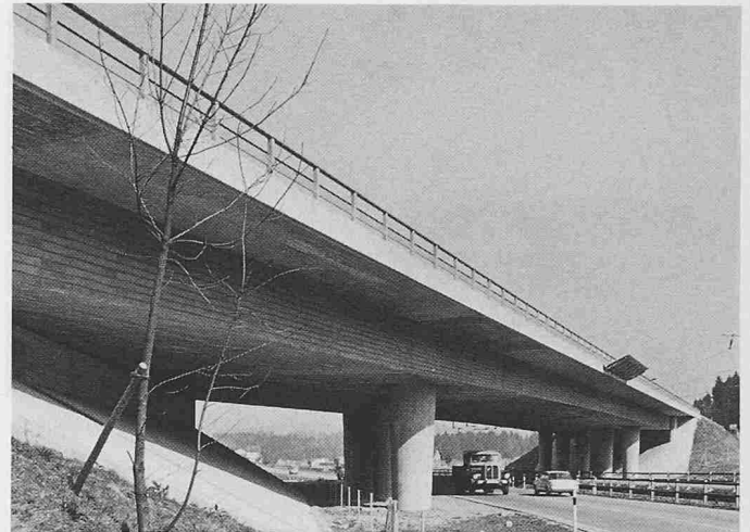
Bild 2. Die schiefe Hohlkastenplatte des Talübergangs, Safenwil (N 1/120) mit tief angesetztem Dienststeg
