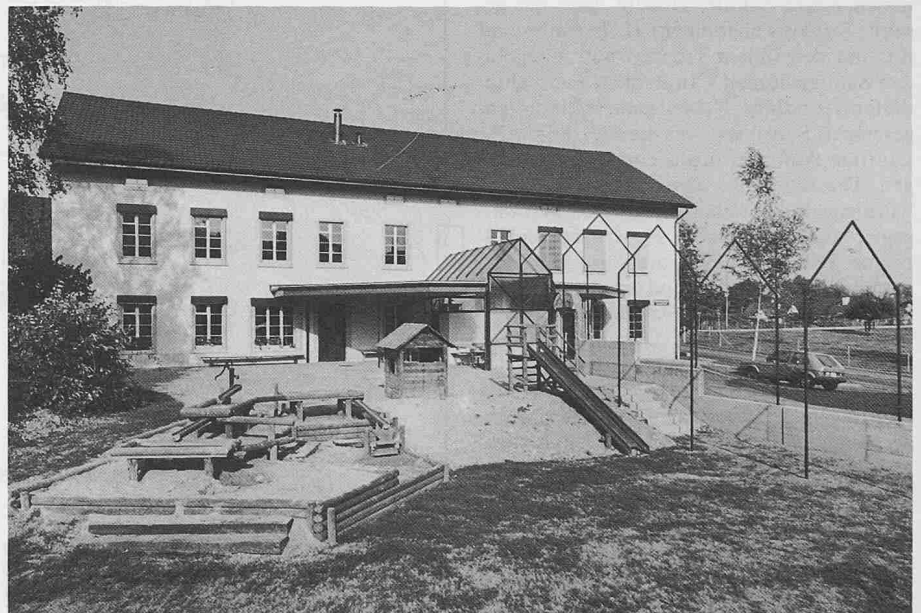
Ostansicht mit Pausenplatz und speziellem Sandwasserspiel
