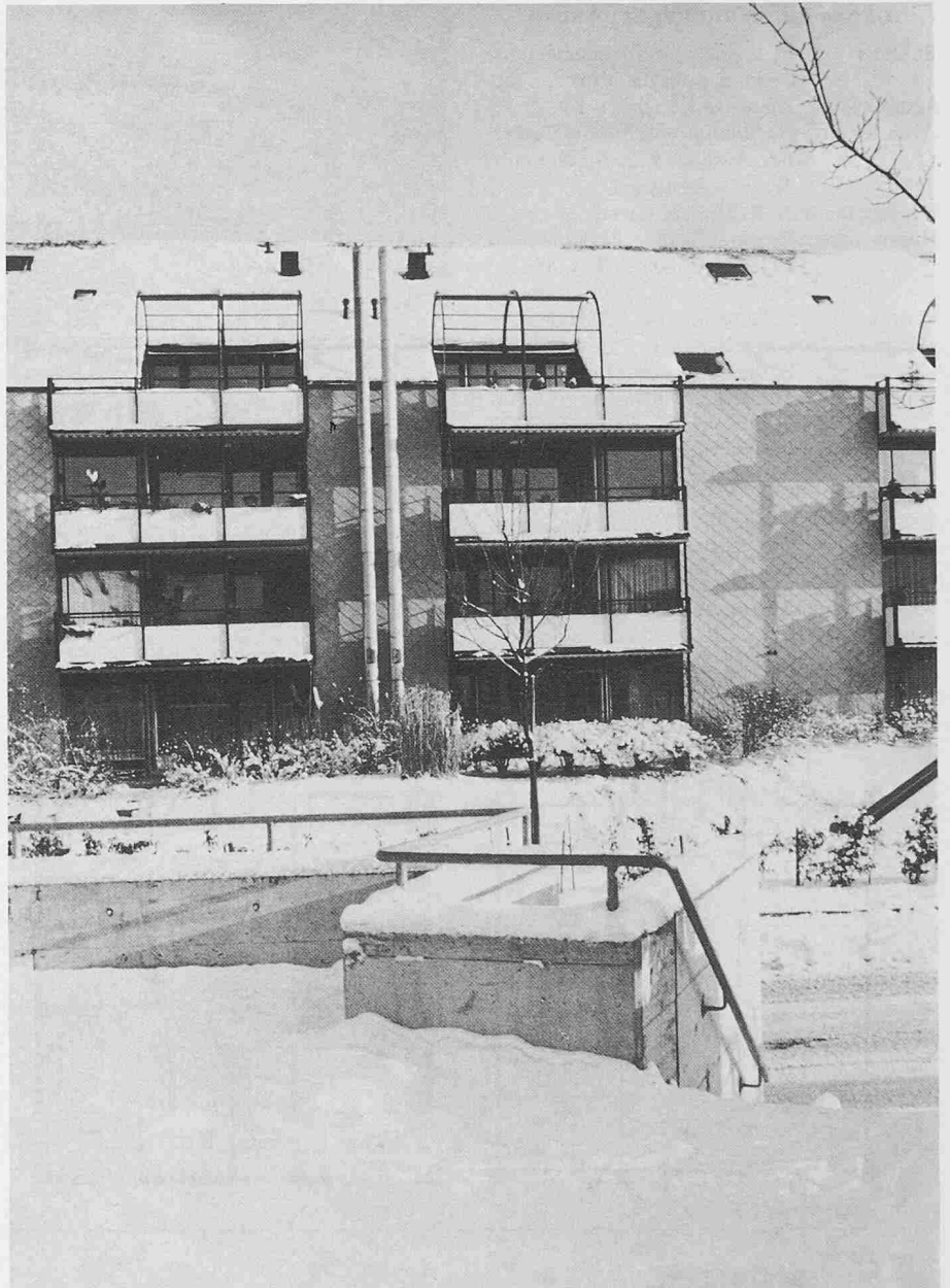
Mehrfamilienhäuser, Westansicht: Wohnen . . .
