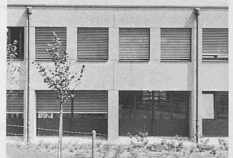
Verwaltungsgebäude (VW), Fassadenausschnitt
