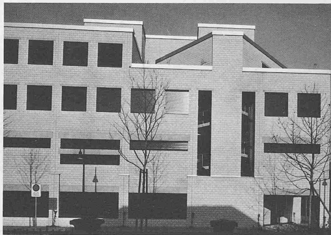
Fassadenausschnitt von Süden
