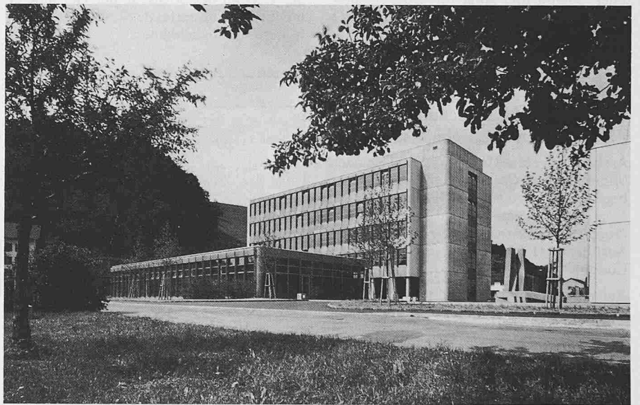
Nord-Ost-Ansicht Schulhaus, Mensa
