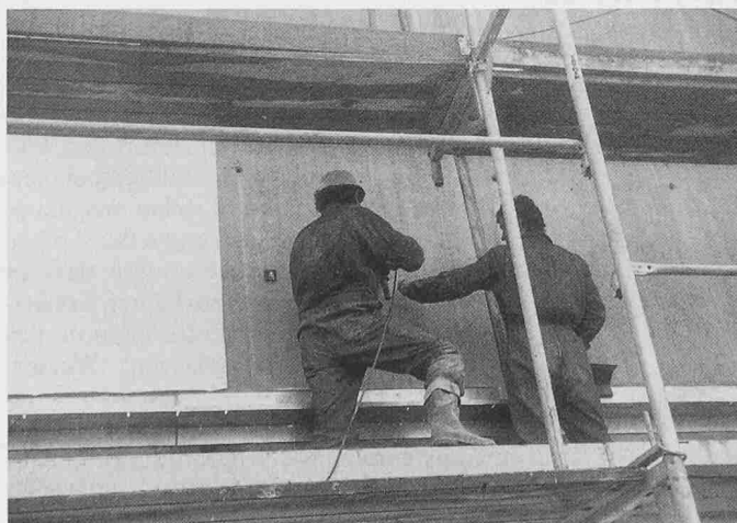
Bild 4. Montage der Dichtungsbahn
