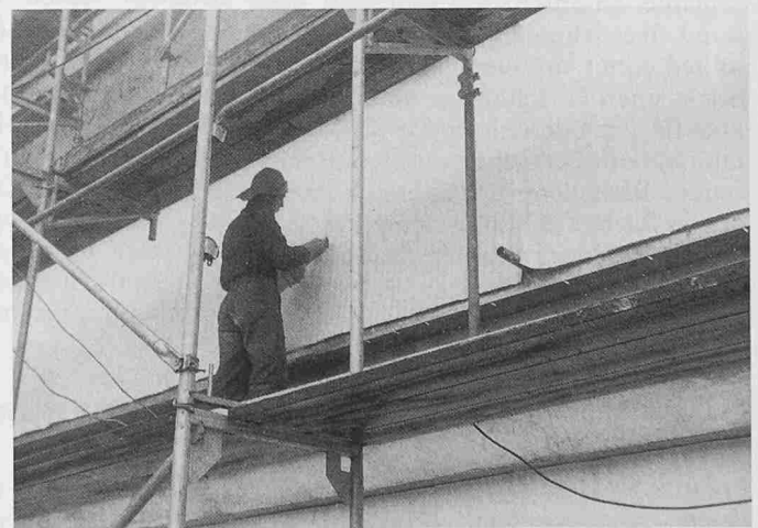
Bild 5. Verschweissen der Bahnstösse
