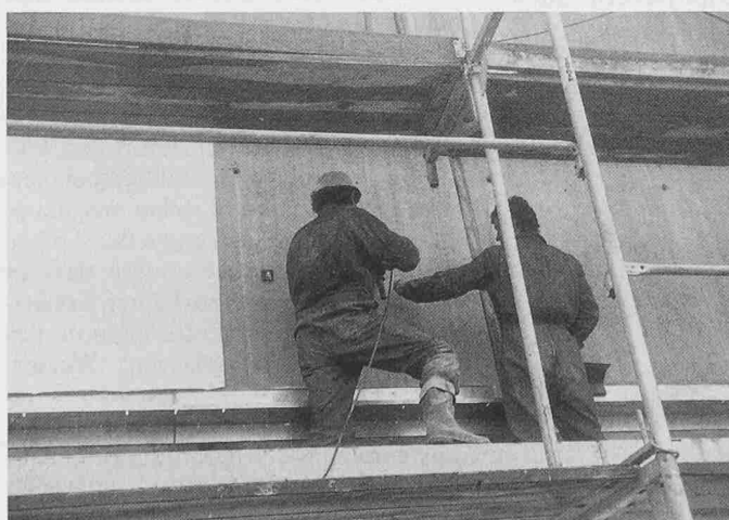
Bild 4. Montage der Dichtungsbahn
