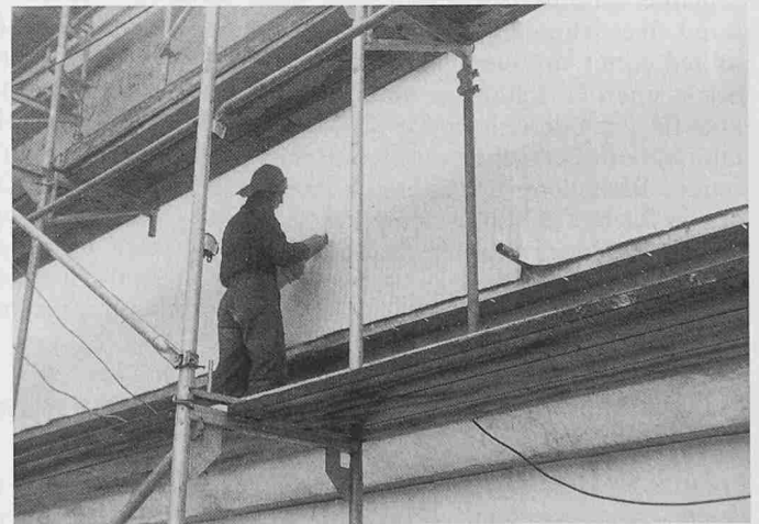
Bild 5. Verschweissen der Bahnstösse
