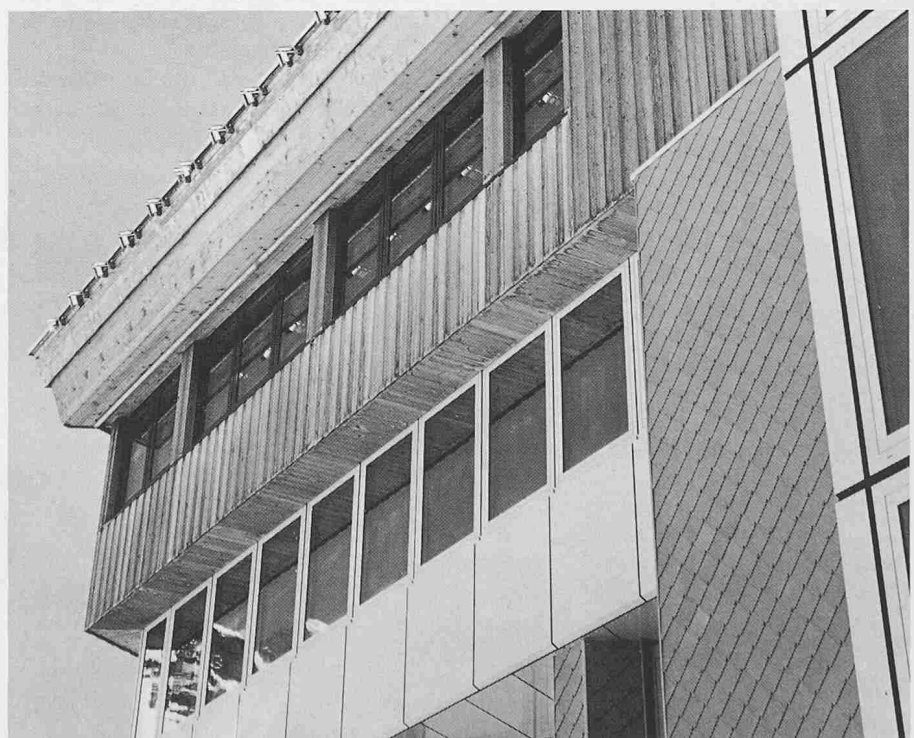
Fassadenausschnitt Ecke Südwest
