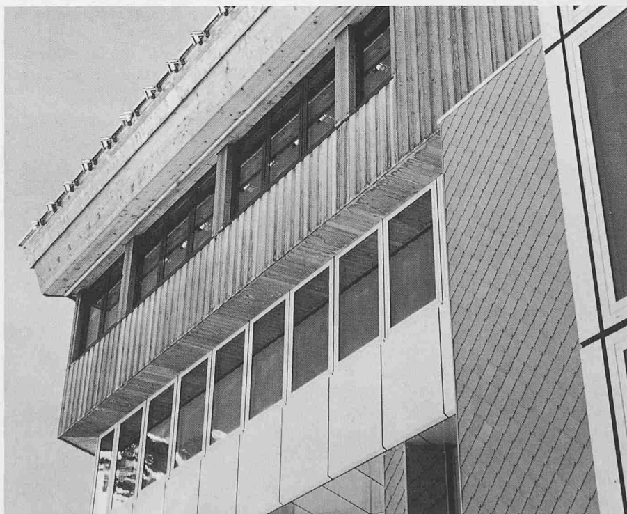
Fassadenausschnitt Ecke Südwest
