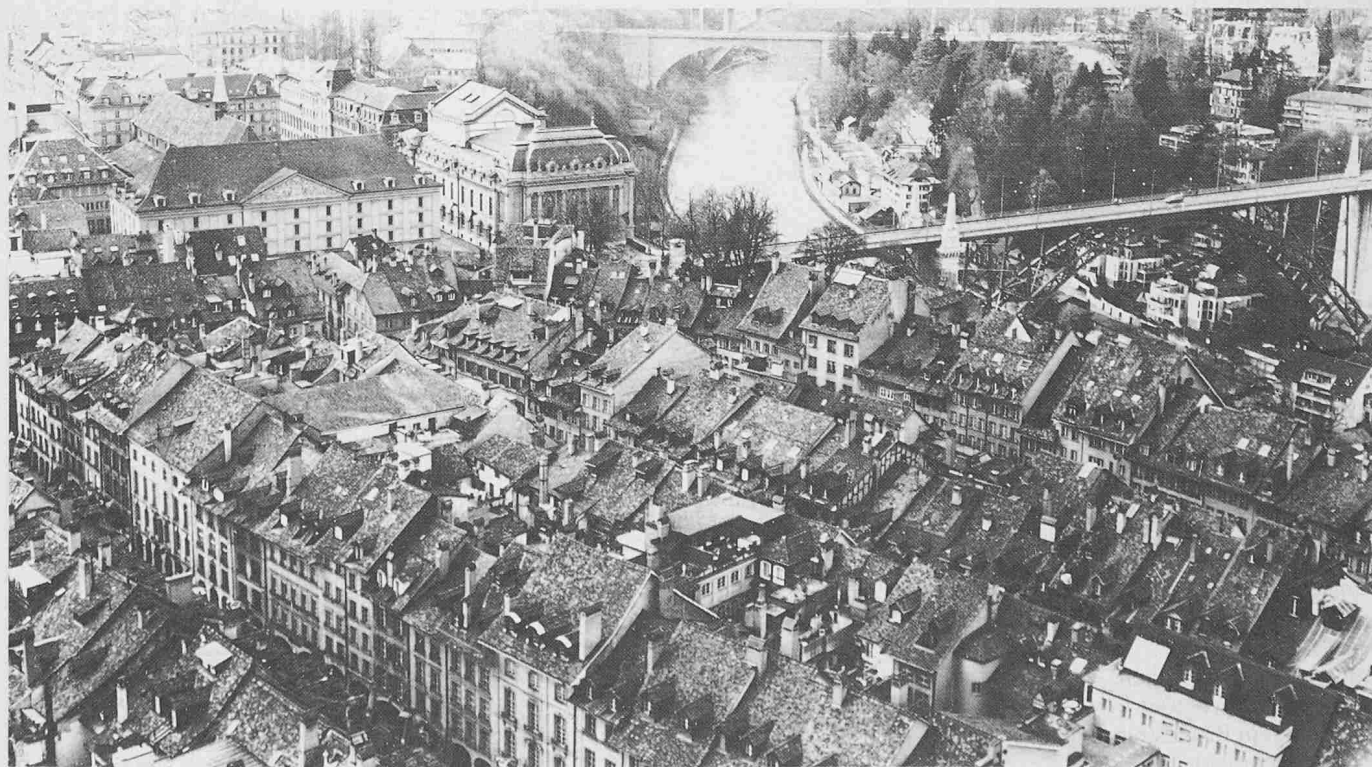
Bild 1. Ein Teil der Dachlandschaft der Berner Altstadt. Grosse Mannigfaltigkeit von Belichtungsaufbauten auf den Dachflächen, mehrere massive Beeinträchtigungen durch Dachbelichtungsaufbauten
