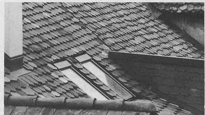
Dachflächenfenster durch Anpassung des Eindeckrahmens abgesenkt: Rahmenhöhe entsprechend Ziegelhöhe
