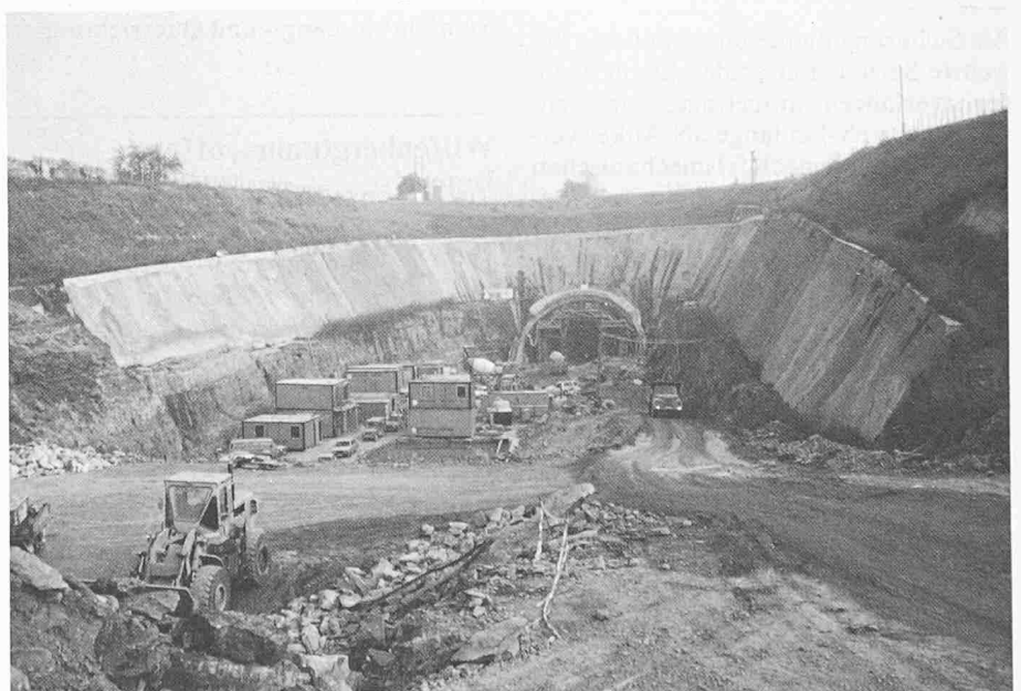
Bild 3. Voreinschnitt West des Rollenbergtunnel
