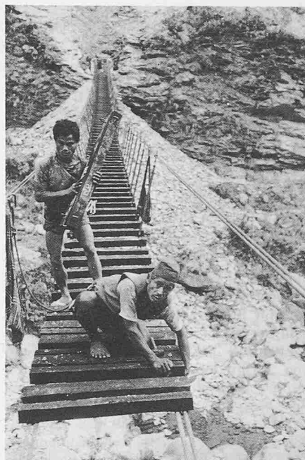
Versetzen des Laufstegs auf der Brücke bei Dundunre, Dhading-Distrikt
